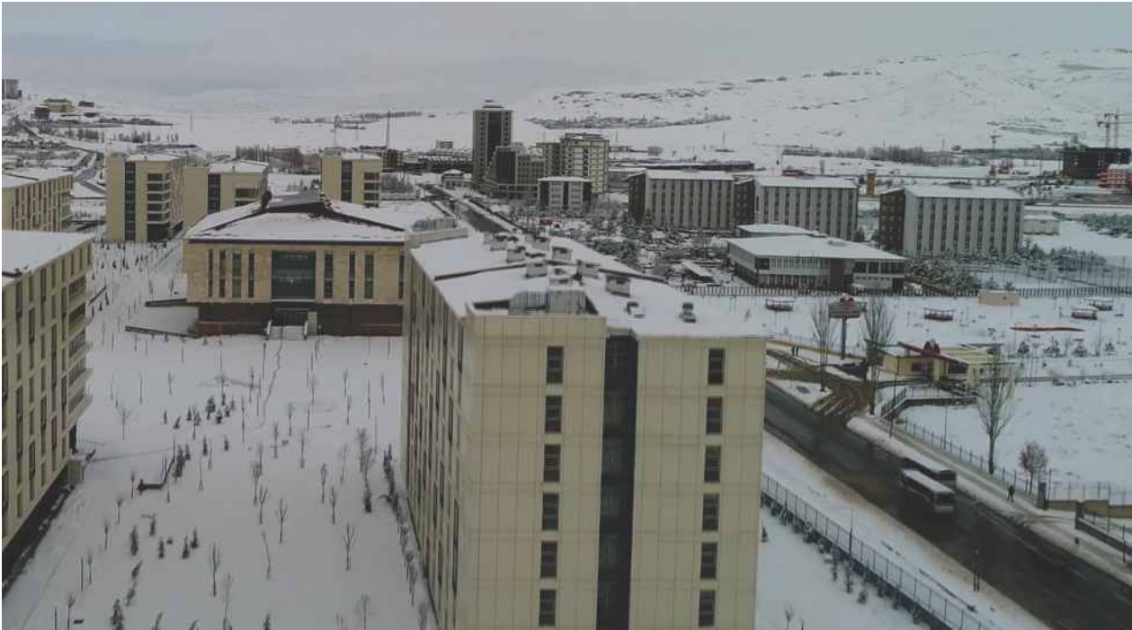
2,250-person Student Dormitory Construction Travaux De Construction Pour La Résidence Étudiante De 2.250 Personnes SİVAS / TÜRKİYE
